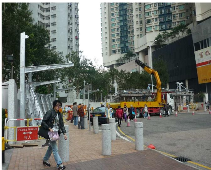
富康花園至將軍澳廣場之間 50 米避雨陰棚工程，較早前已完成地基及 7 支鋼鐵支柱工程，現進行安裝上蓋支柱，行人路已經繼續封閉以便進行安裝上蓋工程，稍後安裝茶色玻璃纖維上蓋，最後是美化 50 米避雨陰棚，陰棚柱是灰色，樑是橙色。
